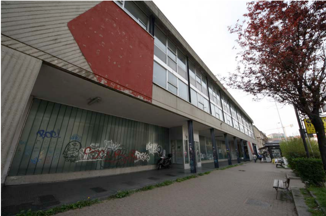
FOTO n° 11 – vista da Corso Francia
