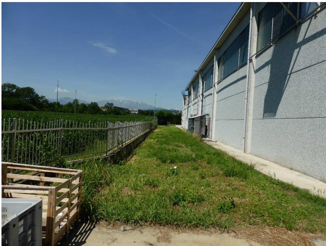
Foto 3. Fronte sud del capannone
