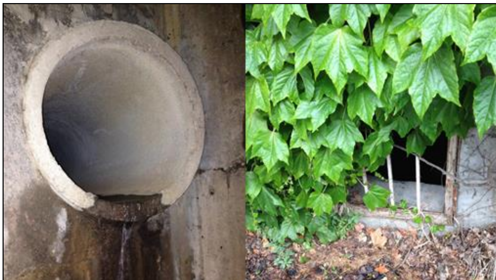
Figura 35: Settore di raccordo del condotto di Vicolo S. Pietro alla fognatura di Via del Parco.
