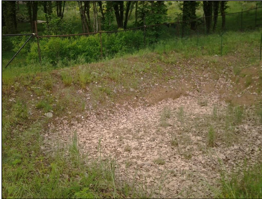
Figura 41 - Vasca di laminazione superiore in terra (cantiere di Villa Melano, adiacente al Parco Pubblico).
