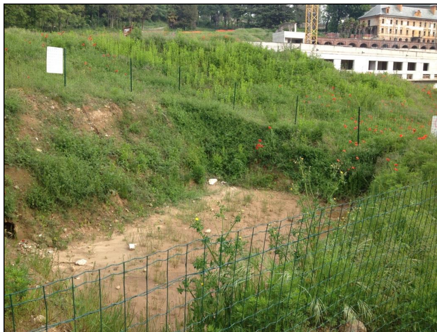
Figura 42: Vasca di laminazione inferiore (cantiere di Villa Melano, prossimo al muro inferiore)
