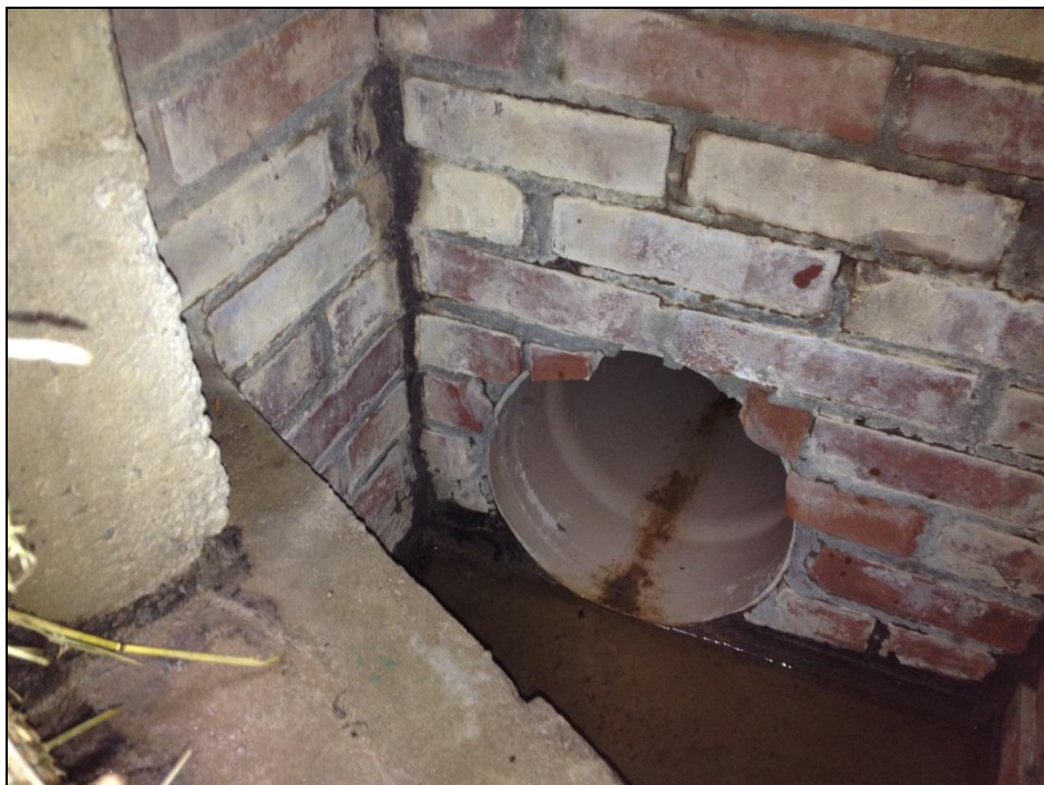
Figura 33 - L'imbocco del tratto in sotterraneo a valle della vasca di calma
