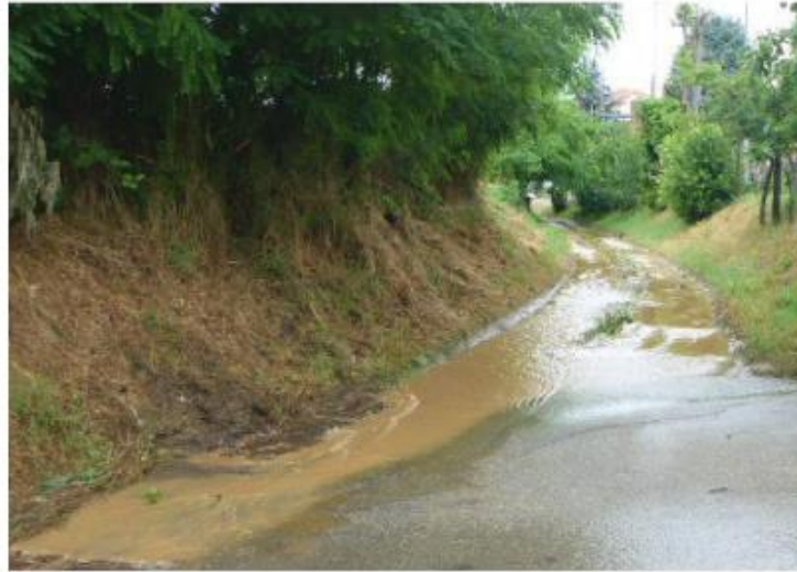
Figura 3 - Strada Vecchia di Rivoli in seguito ad un evento meteorico e ostruzione delle caditoie del sistema fognario misto.
