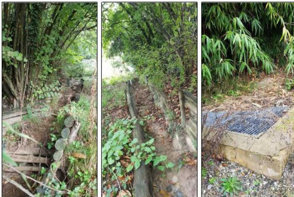
Foto 9 – Canaletta in legname e pietrame esistente e tratto terminale con griglia per immissione nel pozzetto di raccordo con il canale per il Rio Garosso.
