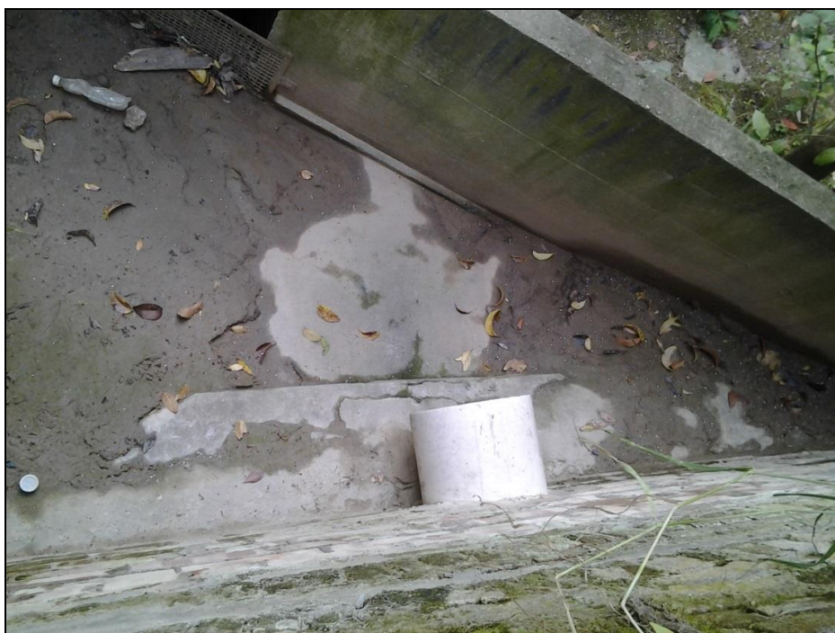
Figura 32 - La tubazione in PVC in uscita dal muro di cinta del parco e della villa.
