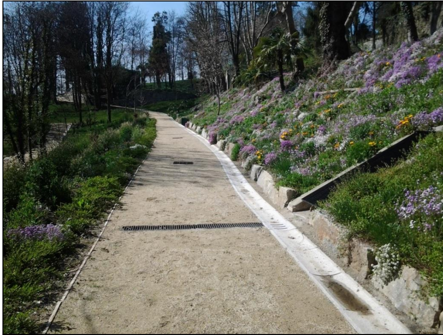
Figura 37 - Canalette di raccolta longitudinali e trasversali nel Parco di San Grato.
