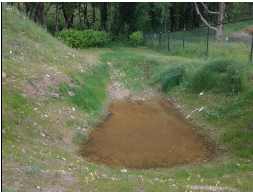
Figura 39 - Vasca di laminazione provvisoria in terra nel Parco Pubblico, al limite con la zona di cantiere, a valle del rilevato di contenimento di cui alla figura precedente
