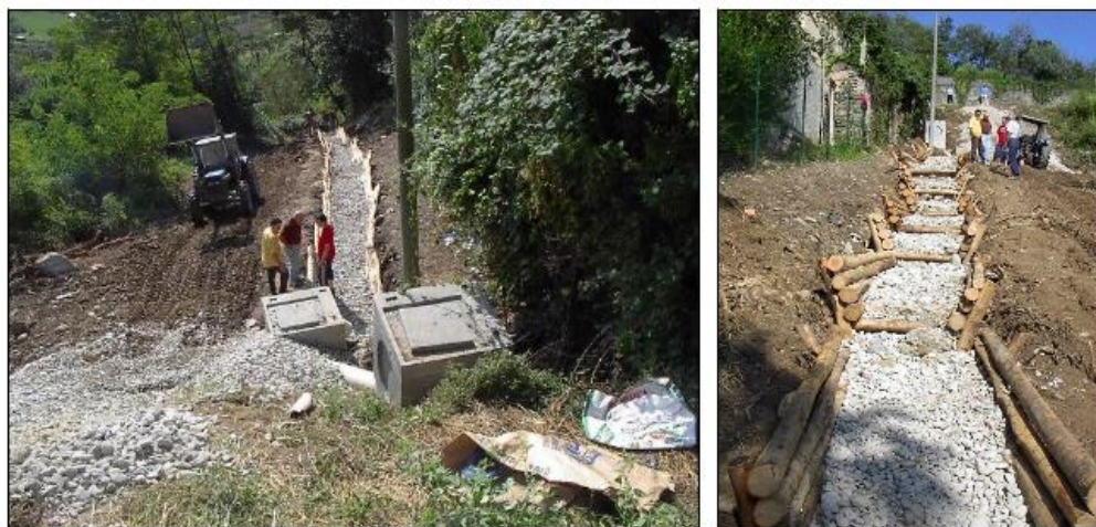
Foto 8 – Immagini scattate in fase di realizzazione dell'intervento.
