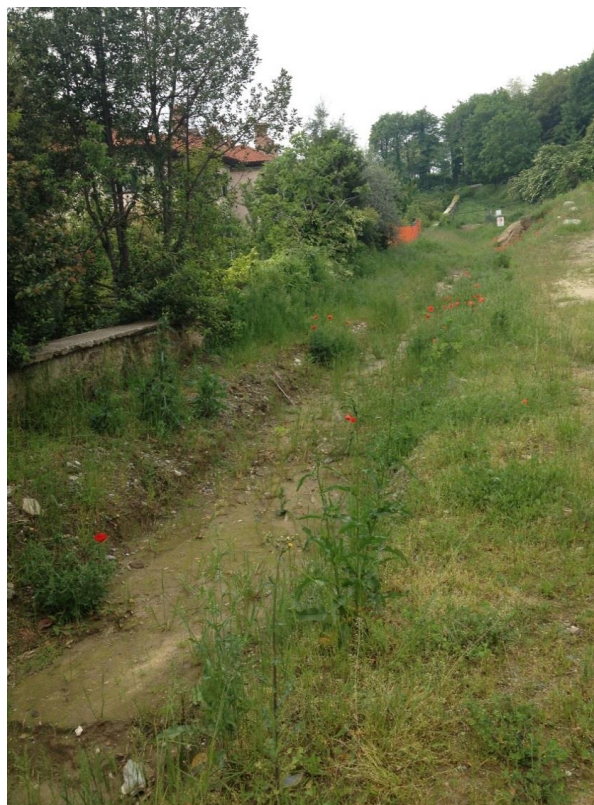
Figura 40: Canalette di raccolta delle acque superficiali, a monte del muro perimetrale a valle del cantiere di Villa Melano
