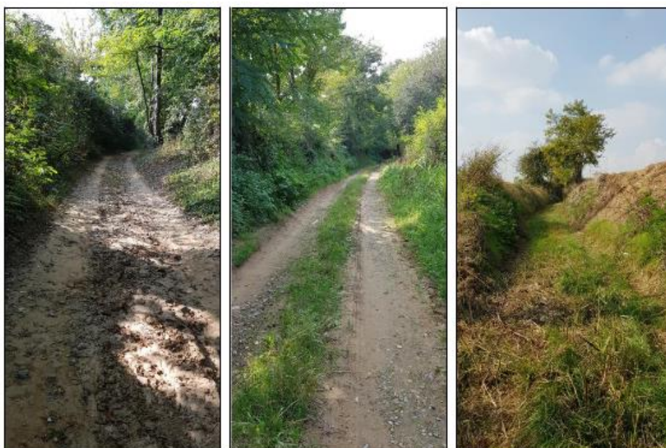
Foto 1 – Strada Vecchia di Rivoli, tratto iniziale che in occasione di eventi pluviometrici intensi diventa veicolo di portata liquida e solida.
