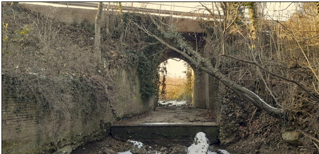
Figura 3 – Attraversamento di Strada Rivalta visto da valle.
