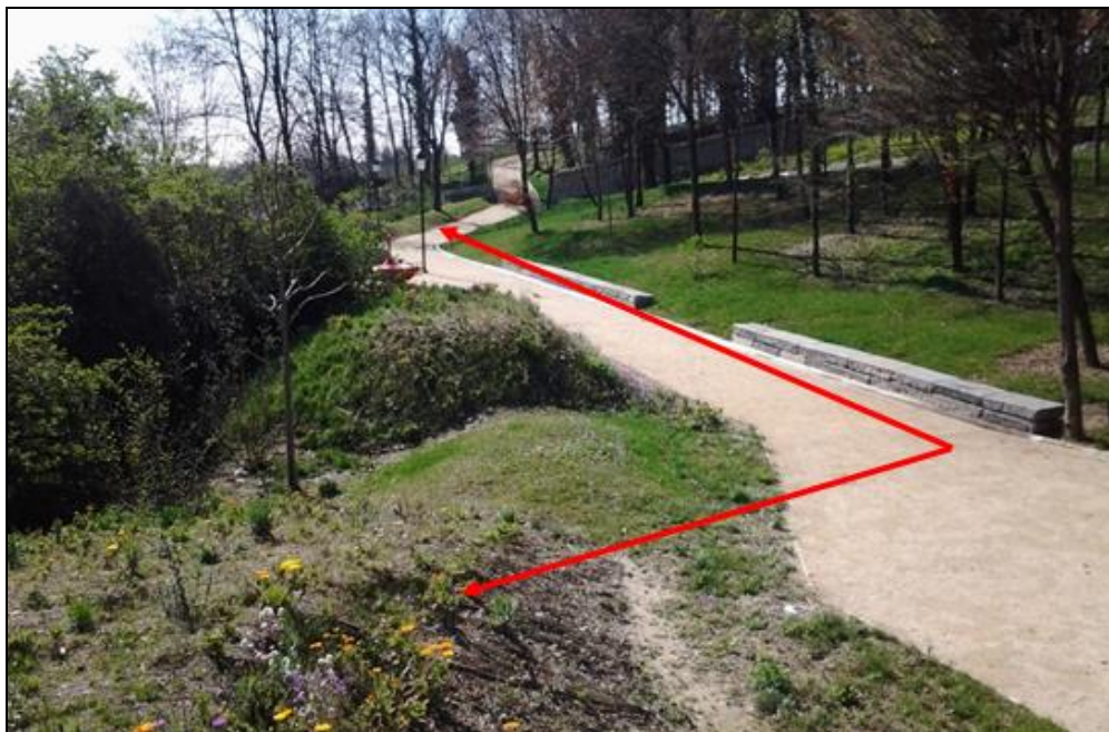
Figura 38 - Rilevato avente funzione di intercettazione dei deflussi altrimenti diretti verso il muro di sostegno di valle del Parco
