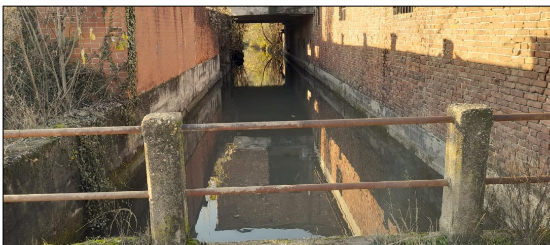
Figura 13 – Canalizzazione che attraversa opificio presso Via Alpignano.
