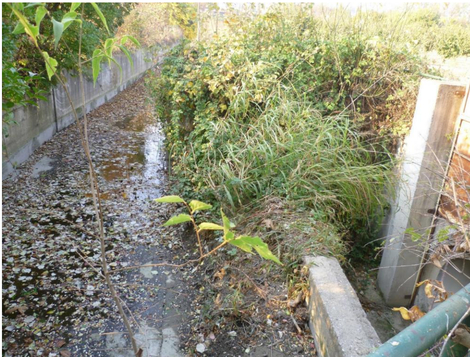
Fig. 8 lo sfioratore del molino
