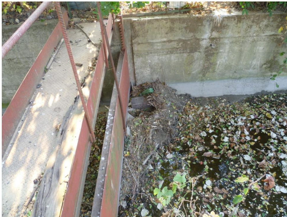
Fig. 9 paratoia posta sul canale a valle dello sfioratore del mulino.
