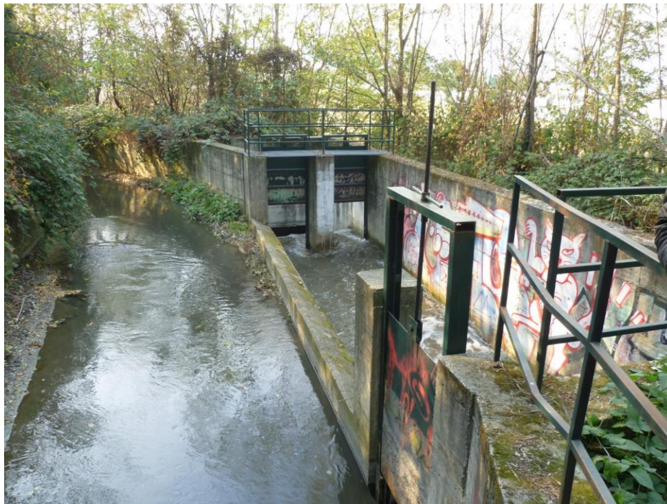
Fig 6 sfioratore di via Paverano
