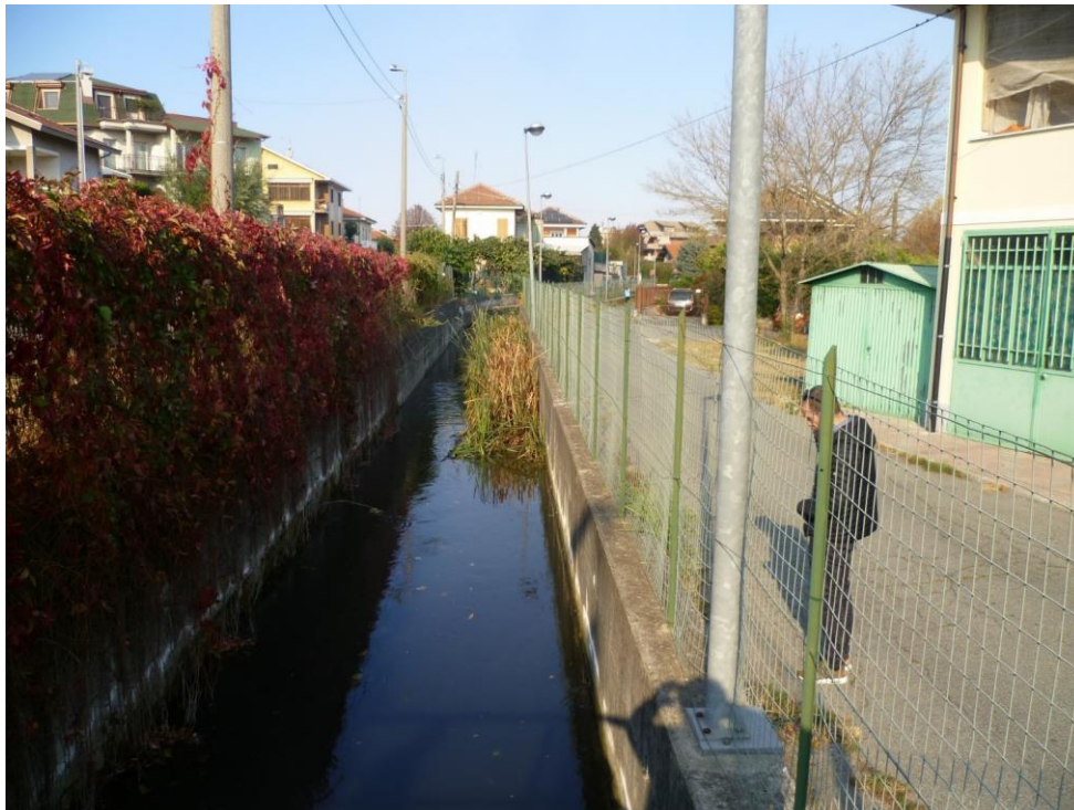
Fig .1 canale di Rivoli in via Alpignano
