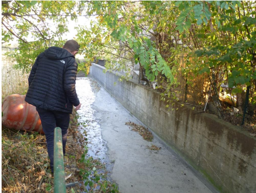
Fig 5 sul fondo il salto in corrispondenza del vecchio mulino
