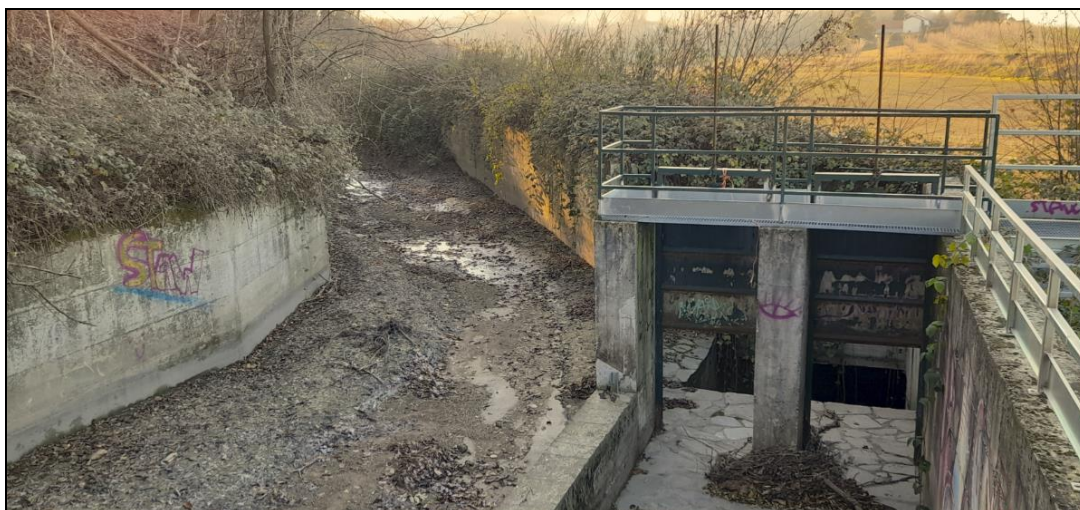
Figura 5 - B. di Rivoli e sfioratore in Loc. Paverano.
