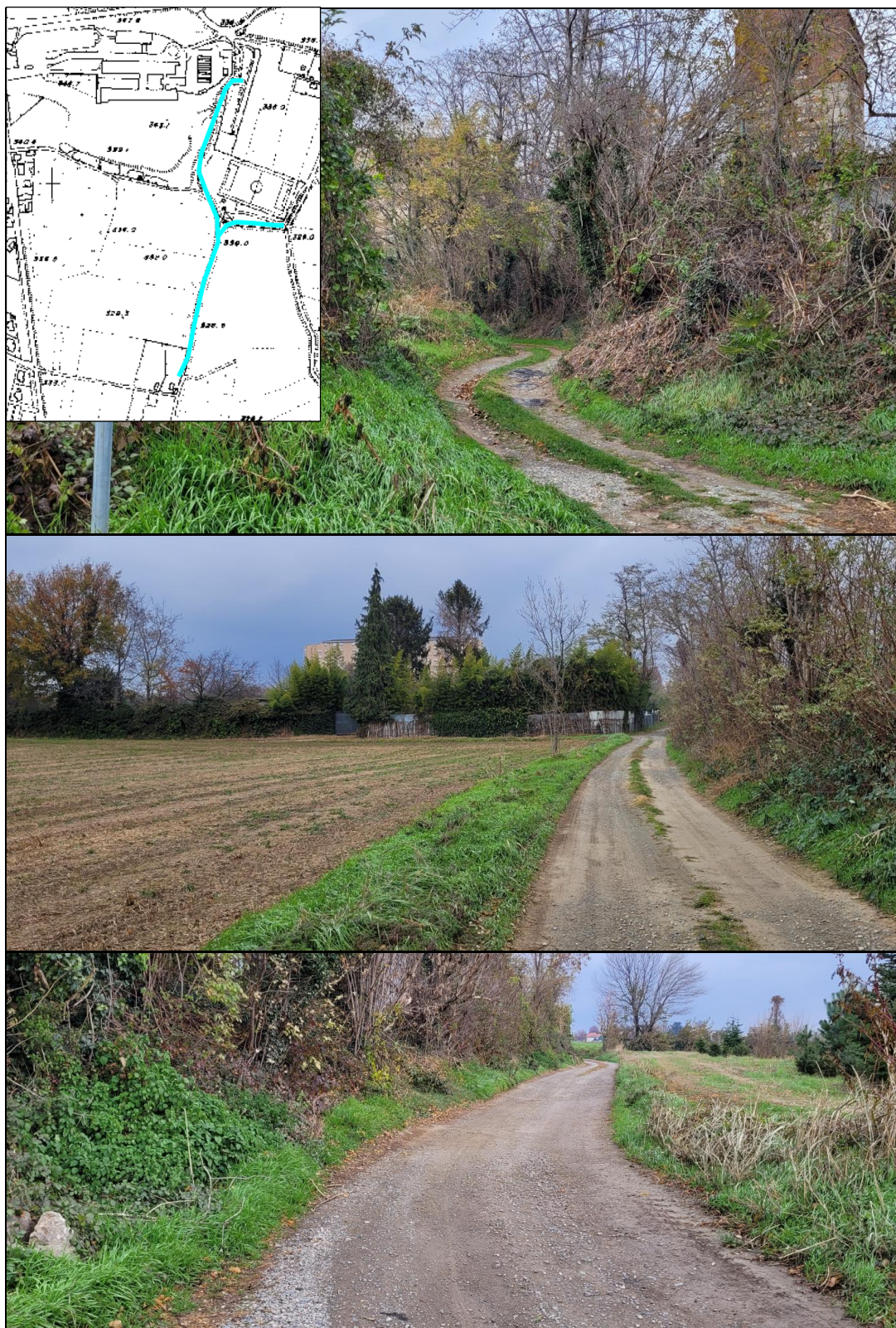
Figura 7 – Assenza di linee di drenaggio lungo Strada vicinale Pongione.
