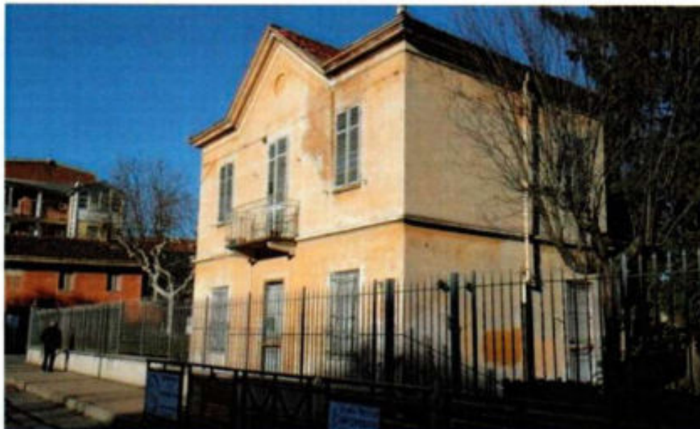
Foto 3: Vista del fabbricato denominato 'Casa del Cappellano', corrispondente al sub. 3
