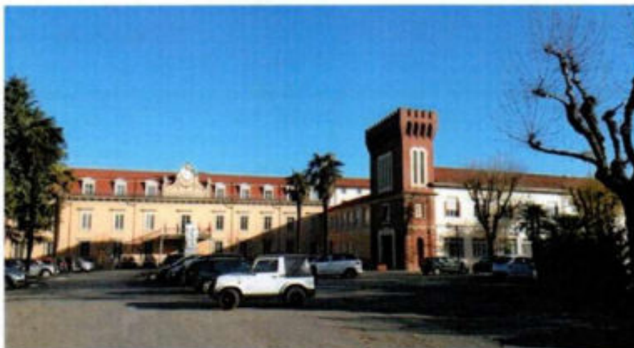
Foto 1: Vista del fabbricato denominato 'Collegio Scuola', corrispondente al sub. 1
