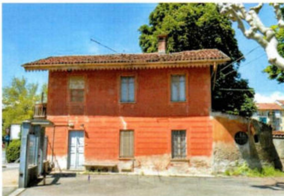
Foto 2: Vista del fabbricato denominato 'Casa del Giardiniere', corrispondente al sub.2
