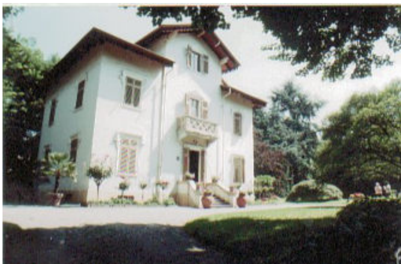
1994 – vista dell'edificio (G.M. Becchi, fotografia, 1994)
