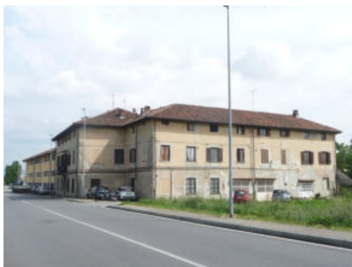
2024 – Vista dell'edificio residenziale della cascina (M. C. Amoroso)
