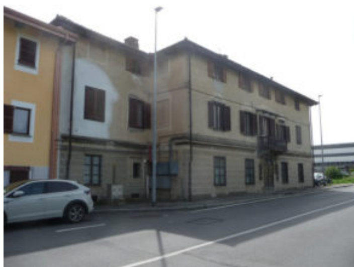
2024 – Vista dell'edificio residenziale della cascina (M. C. Amoroso)
