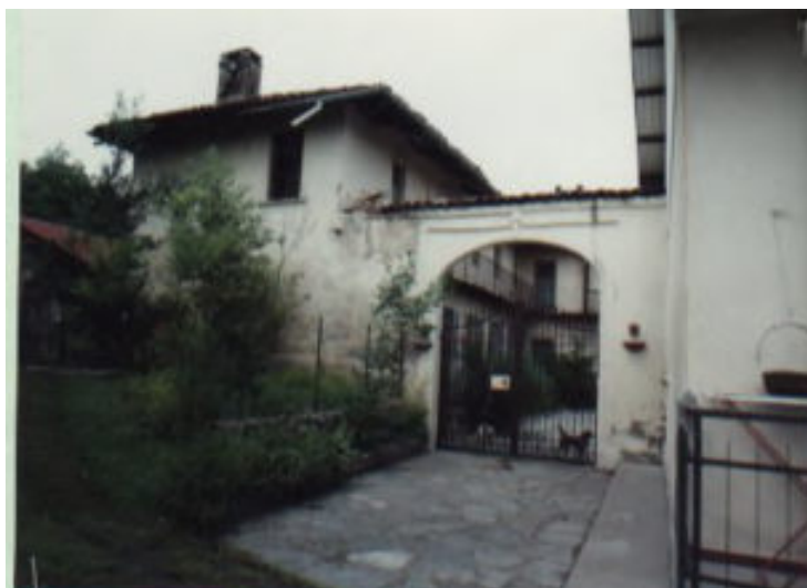
1994 – Vista dell'ingresso alla cascina (G.M. Becchi)
