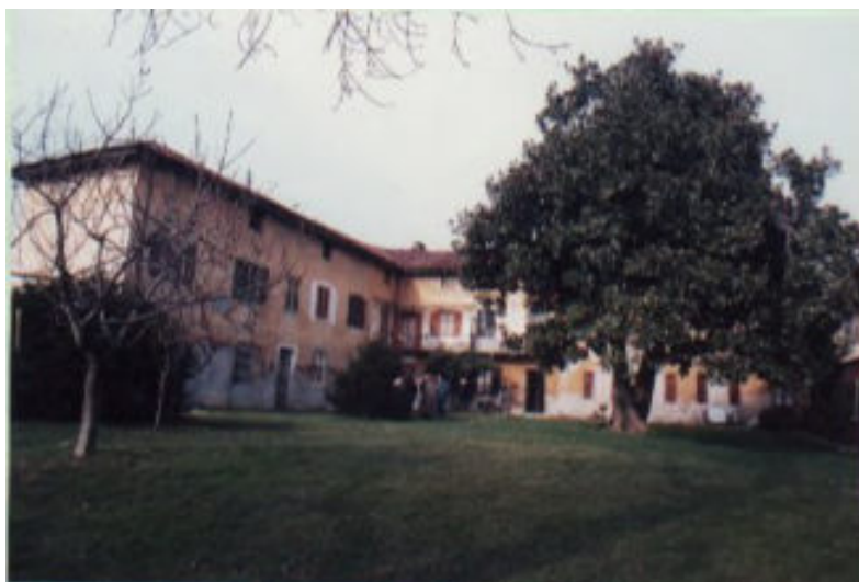
1994 – Vista dell'edificio residenziale dall'area di pertinenza (G.M. Becchi)
