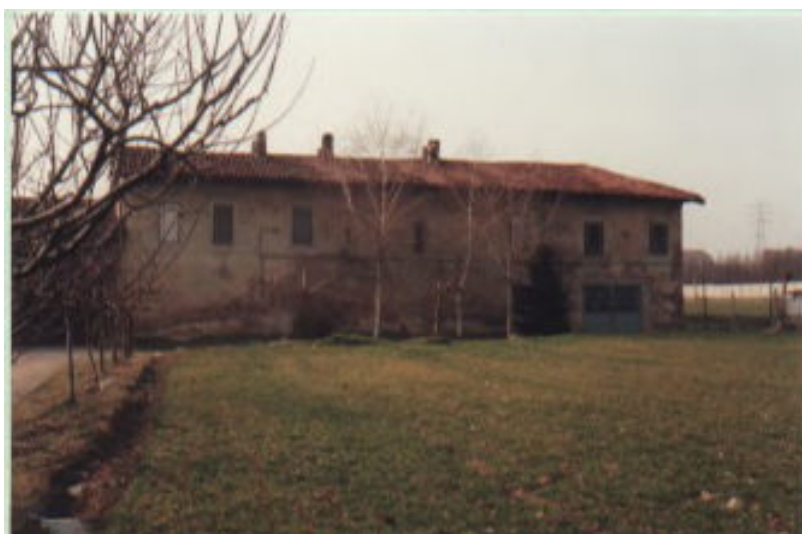
1994 – Vista dell'edificio rustico dall'area antistante l'ingresso (G.M. Becchi)
