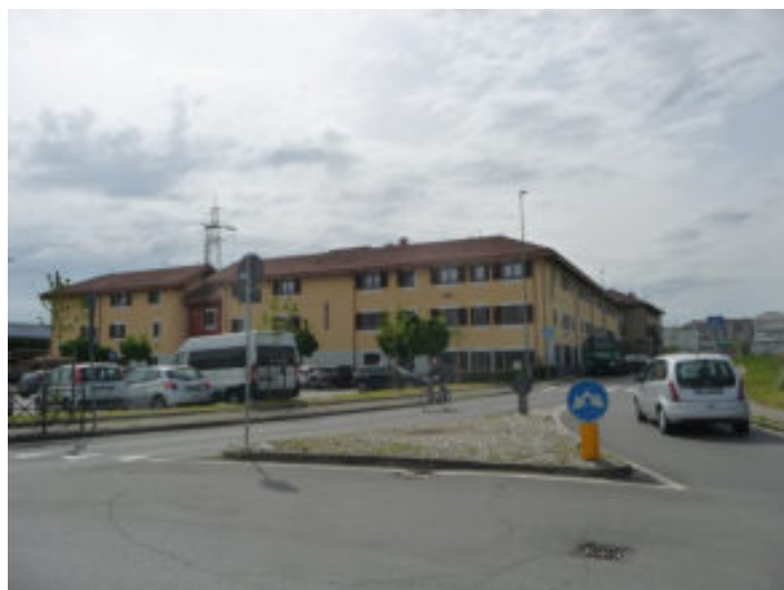
2024 – Vista del nuovo edificio residenziale (M. C. Amoroso)
