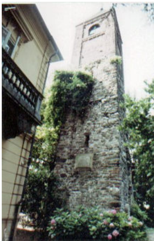
1994 – Veduta della torre del Salvatore (G.M. Becchi)
