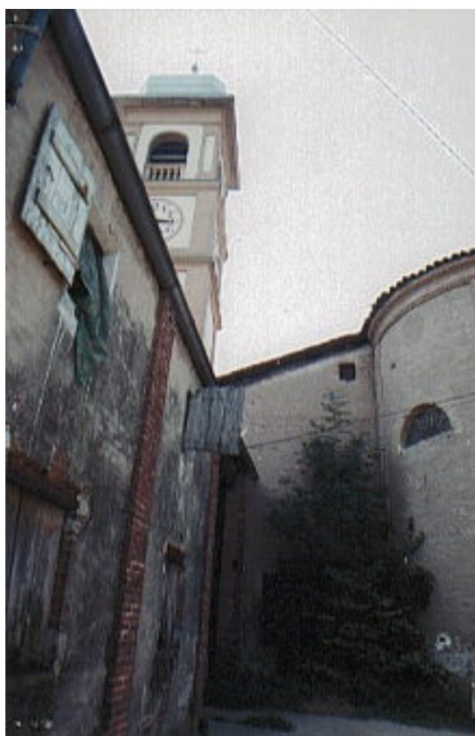
1994 – Vista della chiesa e della torre campanaria (G.M. Becchi)
