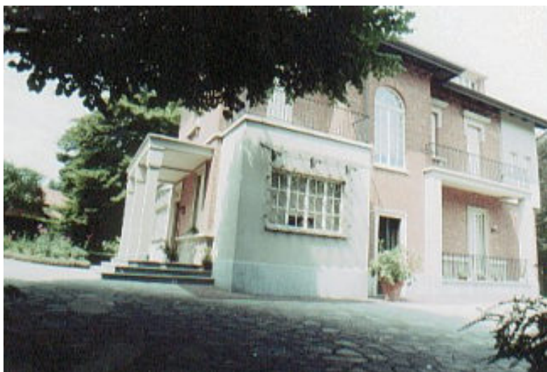
1994 – vista dell'edificio (G.M. Becchi, fotografia, 1994)
