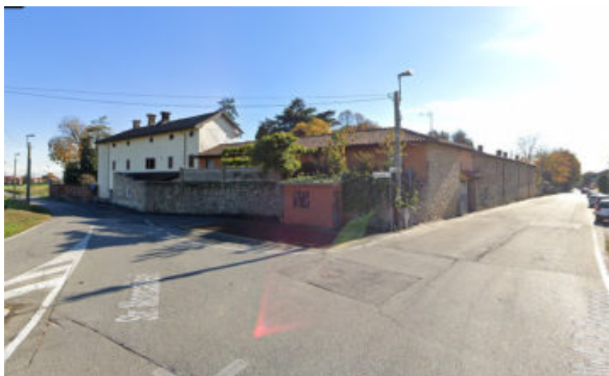
2024 – Vista del complesso edilizio (www.gogle.it/maps)
