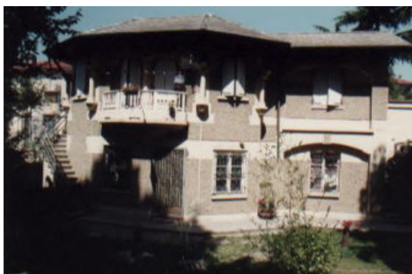
1994 - Vista della casa del custode (G.M. Becchi, fotografia, 1994)
