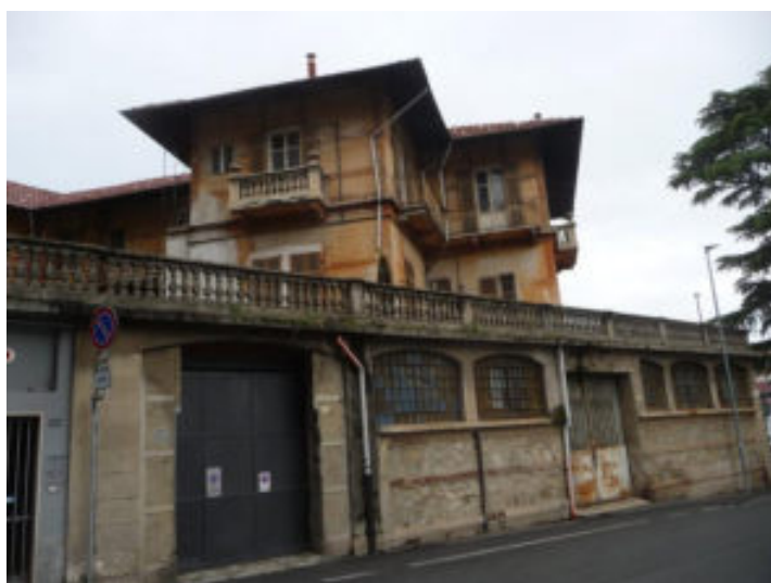
2024 – vista del complesso edilizio dalla via N. Leumann (M. C. Amoroso)
