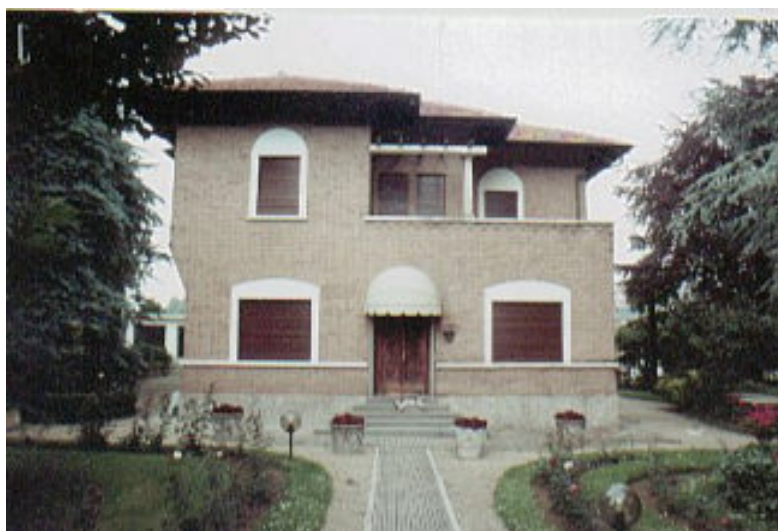
1994 – vista dell'edificio (G.M. Becchi, fotografia, 1994)
