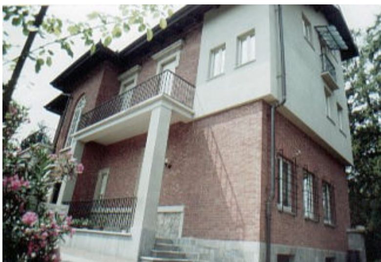
1994 – vista dell'edificio (G.M. Becchi, fotografia, 1994)
