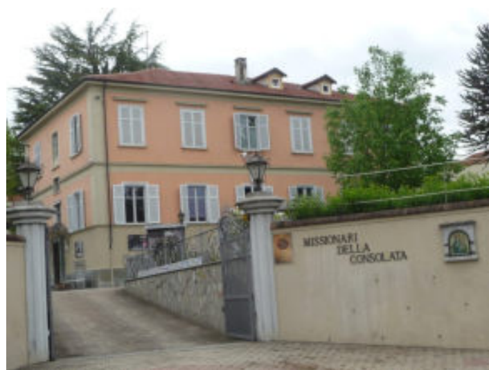
2024 – vista dell'edificio dall'ingresso (M. C. Amoroso)
