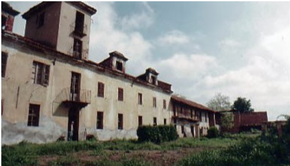
1994 – Vista dell'edificio prospiciente la corte interna – parte residenziale e parte rustica (G.M. Becchi)
