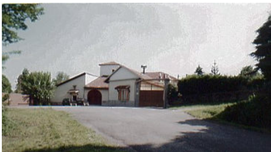
1994 – Vista dell'ingresso alla cascina (G.M. Becchi)
