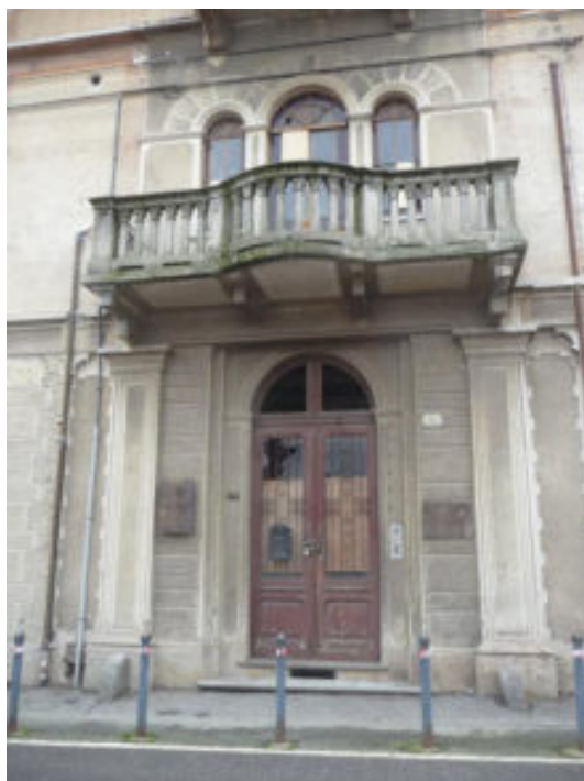
2024 – Ingresso principale all'edificio residenziale (M. C. Amoroso)
