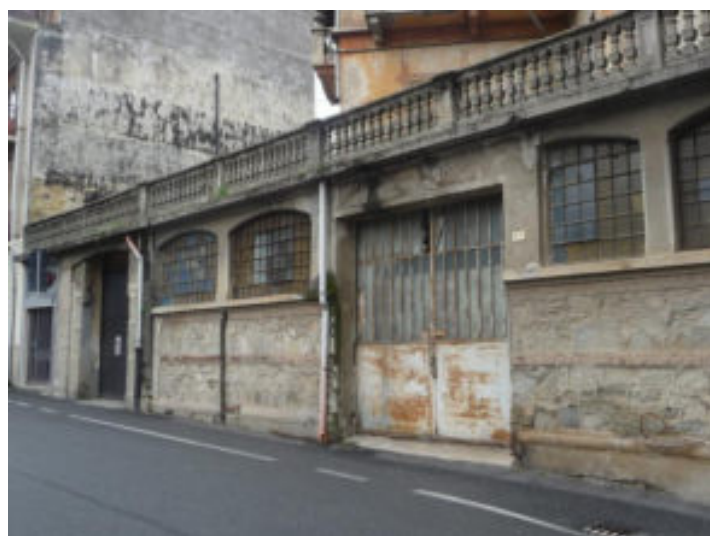
2024 – Dettaglio della facciata del fabbricato industriale (M.C. Amoroso)
