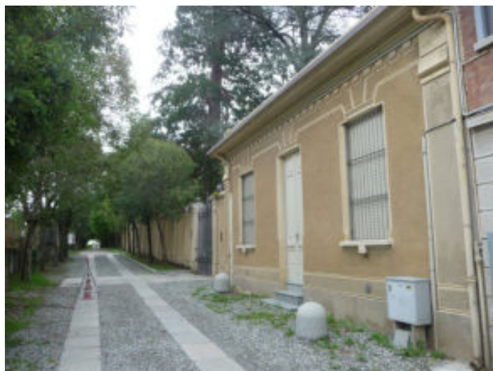
2024 – Vista basso fabbricato (pertinenza della villa) (M. C. Amoroso)
