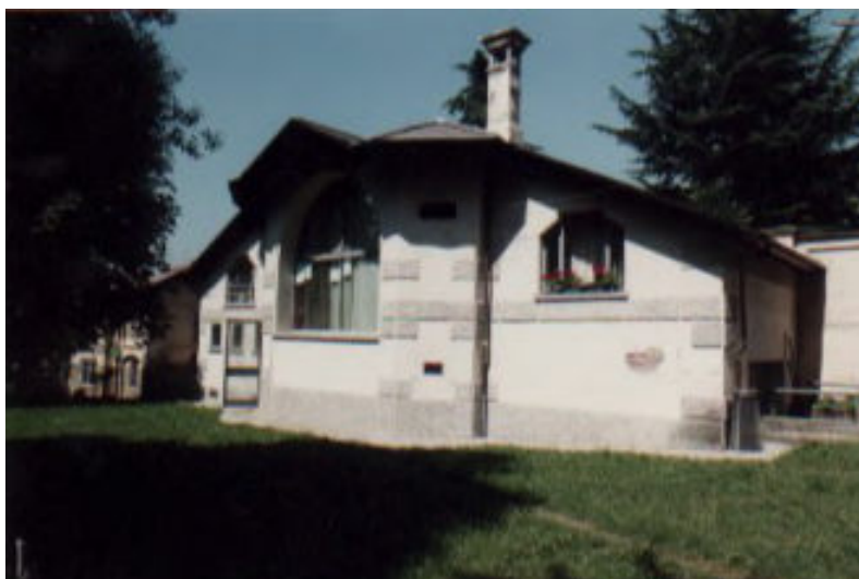
1994 - Vista dell'edificio della direzione didattica, già rustico-lavanderia (G.M. Becchi, fotografia, 1994)
