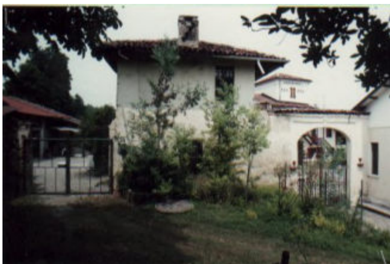
1994 – Vista dell'ingresso alla cascina (G.M. Becchi)
