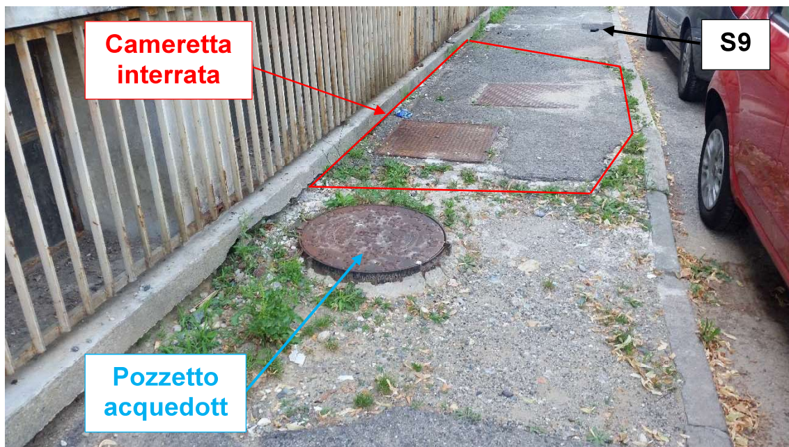
Fig. 2.1. Ubicazione del sondaggi S9 e presenza di sottoservizi (cameretta interrata e pozzetto acquedotto).
