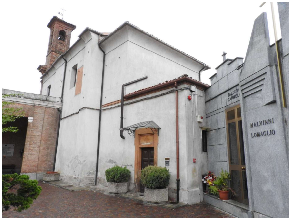
Vista delle nuove gronde installate presso la copertura sulla Sacrestia
