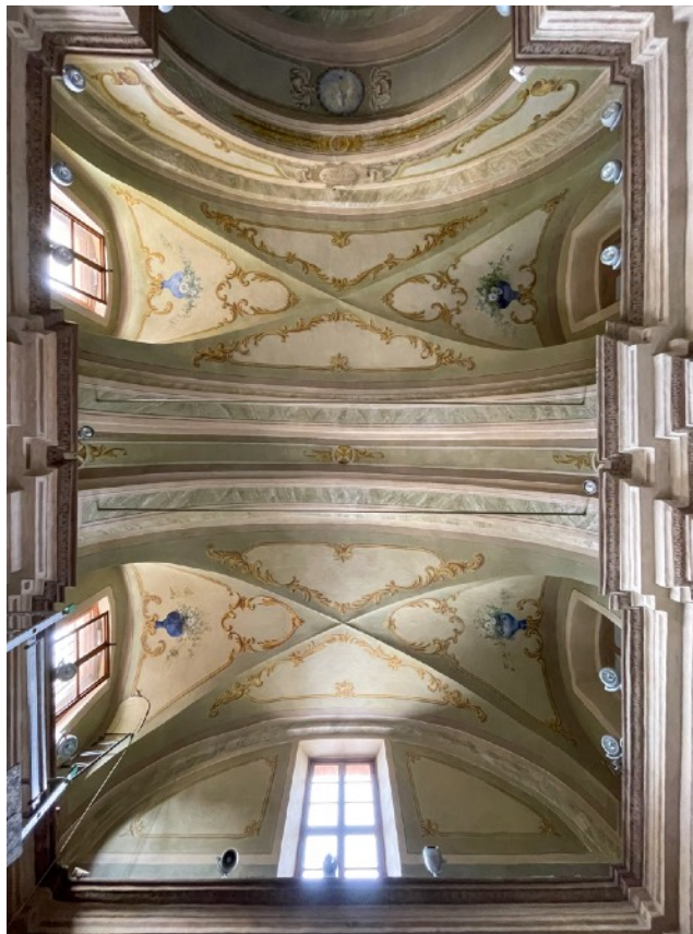
Fig. 6 La volta dopo il restauro
