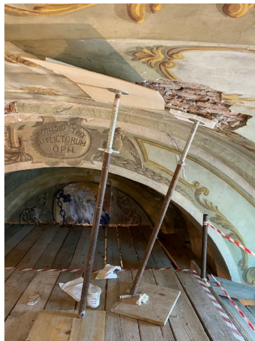
Fig. 2 Puntellatura dell'intonaco durante il consolidamento.
