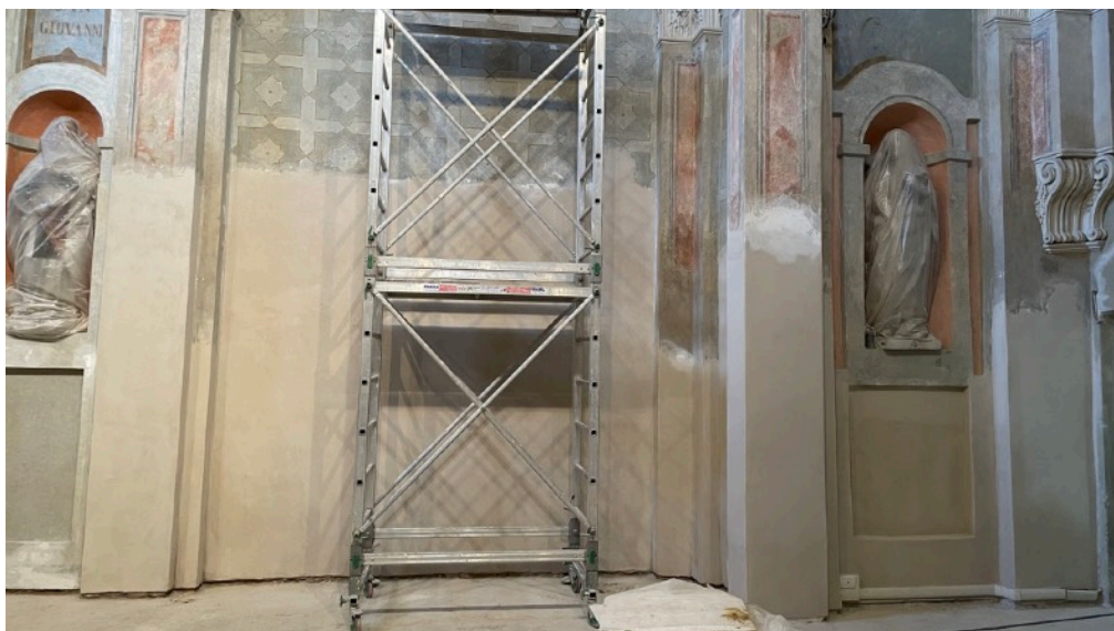
Fig. 18 Parete nord dell'aula, dopo l'intonacatura con intonaco deumidificante
