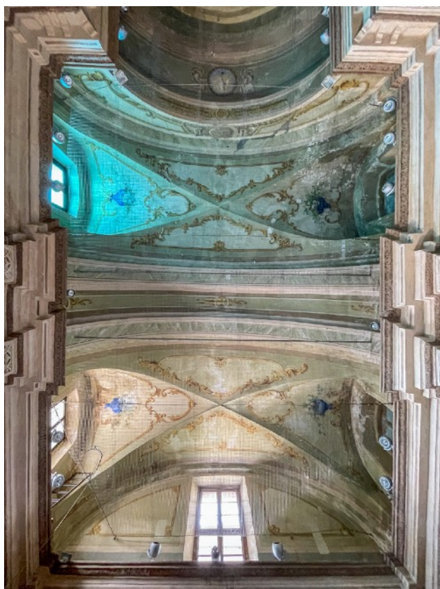
Fig. 5 La volta prima del restauro
