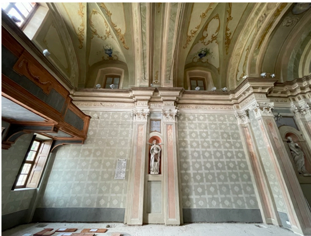
Fig. 19 Parete nord dell'aula, dopo il restauro.
