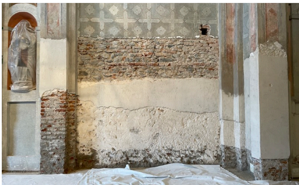
Fig. 17 Parete nord dell'aula, dopo la rimozione degli intonaci non originali inidonei
