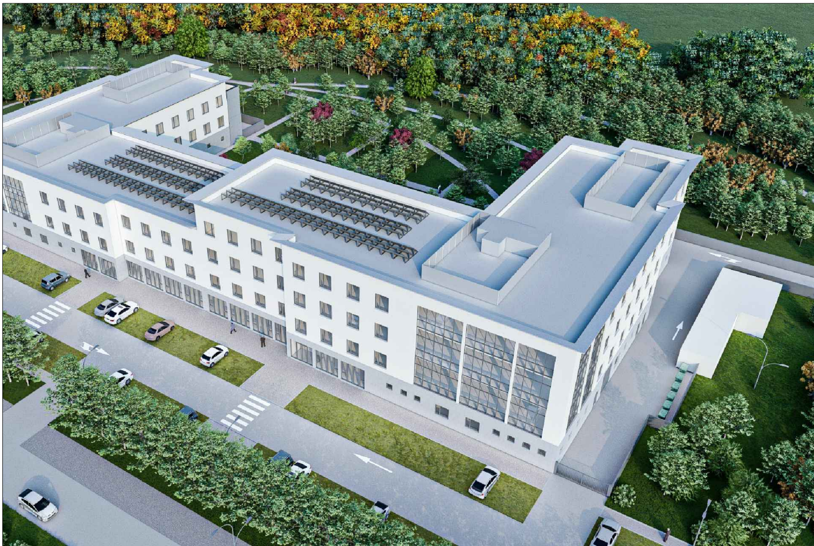
IMMAGINE N° 02 - LATO NORD-OVEST VISTA DALL'ALTO
