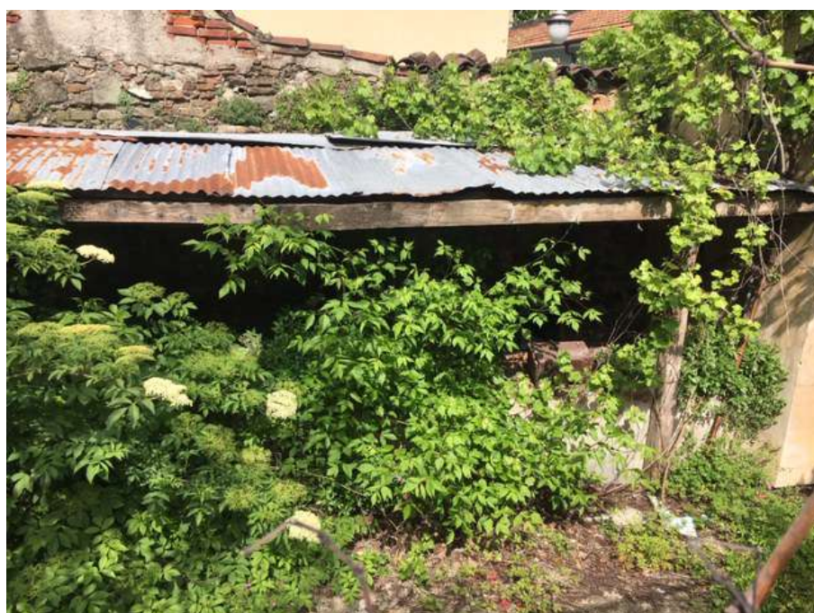
Vista Interno cortile
