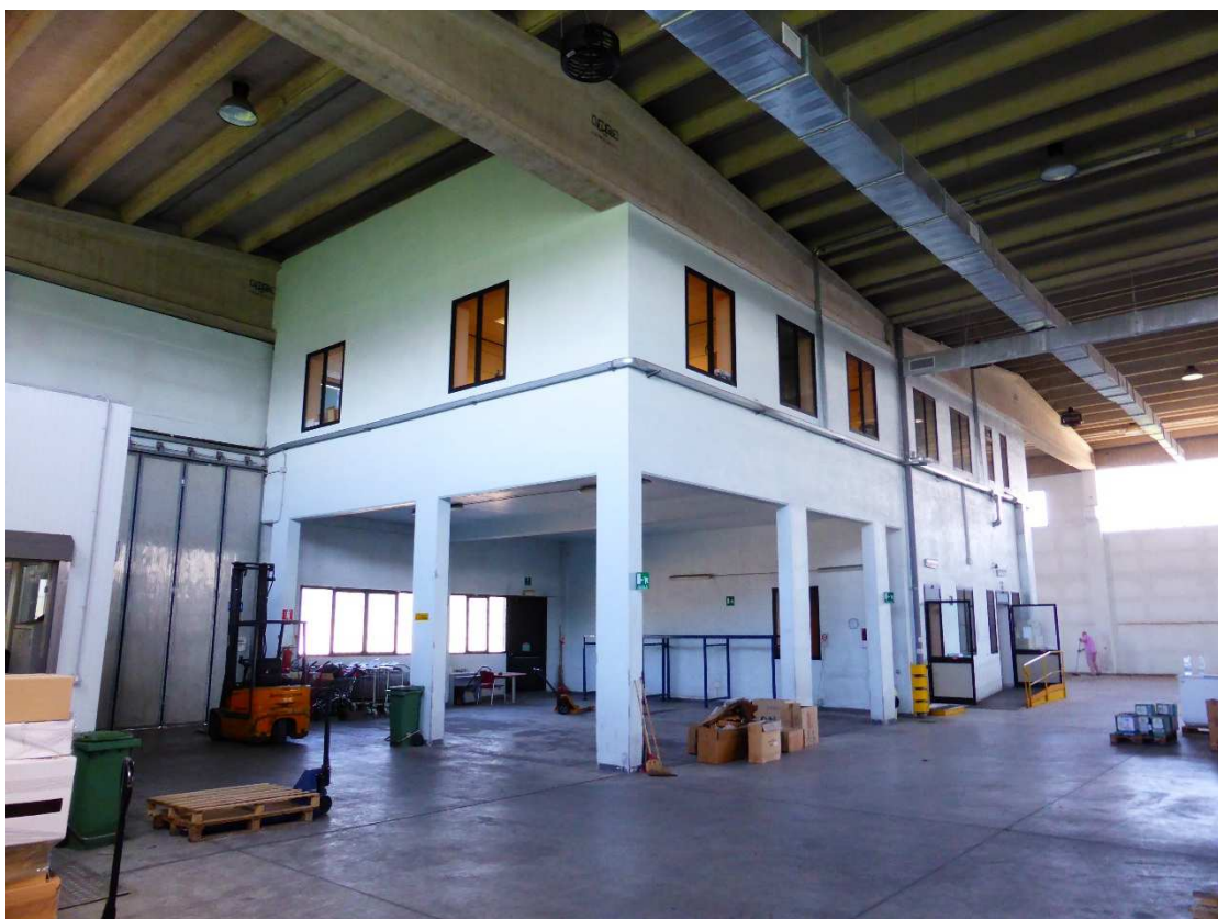
Foto 6. Vista interna del capannone
