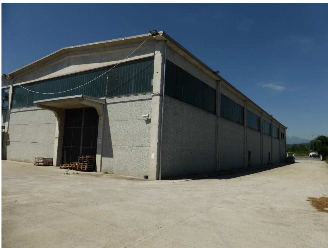
Foto 2. Fronte nord-est del capannone
