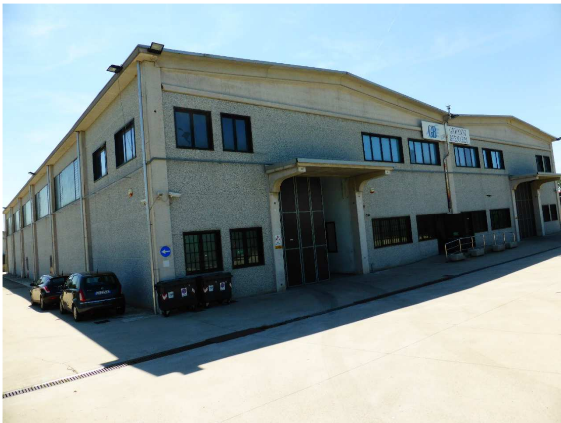
Foto 1. Fronte ovest del capannone
