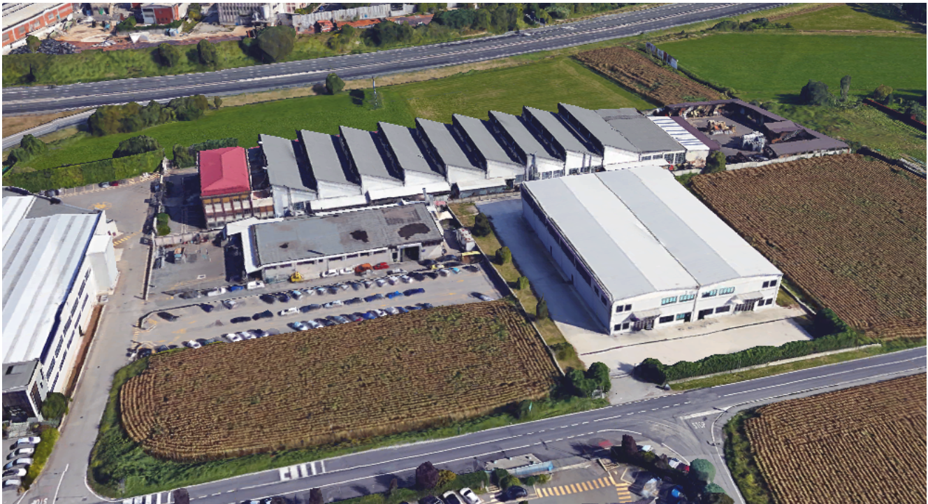
Fig. 1: Identificazione dell'area dove è ubicato il capannone da adibire a magazzino
