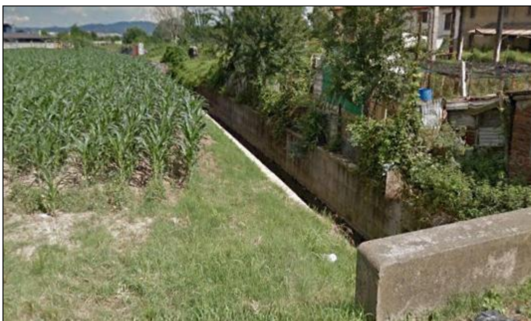
Figura 4b – Il tratto delle bealera a valle di Corso IV Novembre, ripresa dalla strada.
